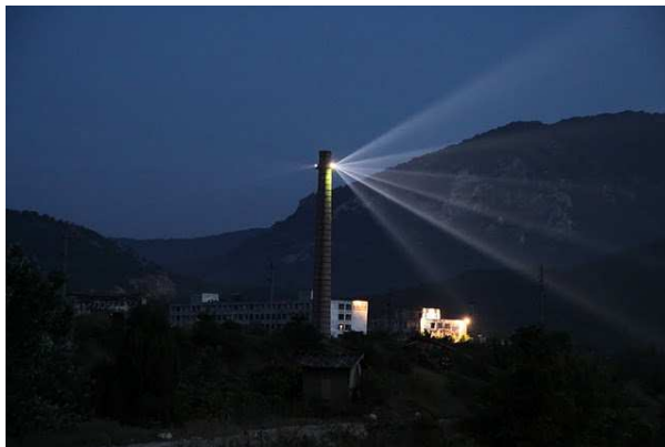
Oświetlenie na kominie
